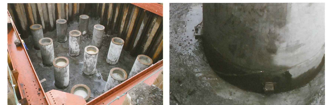
施工後の杭頭部掘削状況
